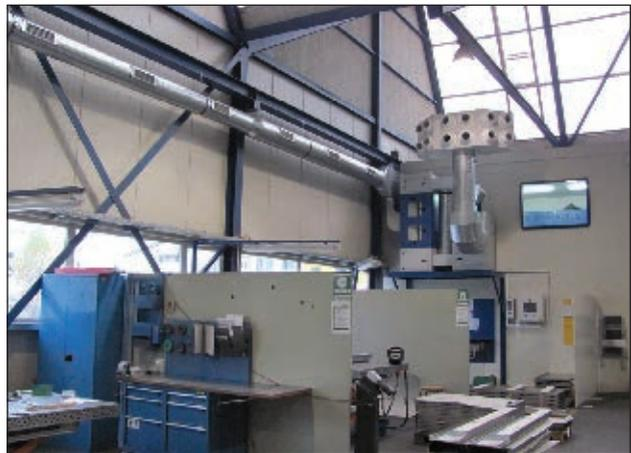
Система приточно-вытяжной вентиляции ТЕКА
