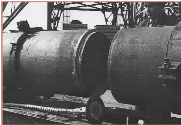
Рис. 3. Сборка монтажных стыков
