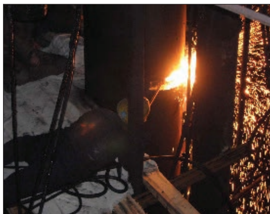
Рис. 1. Кислородная резка северо-восточной колонны пресса
