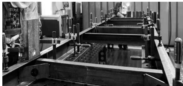
Рис. 15. Сварка рамной конструкции для строительства
