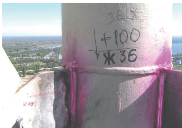
Рис. 12. Старая и новая вентиляционные трубы. Капиллярный контроль элементов каркаса новой вентиляционной трубы Чернобыльской АЭС
