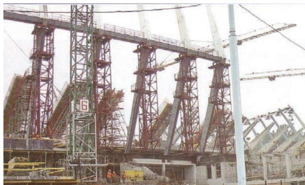
Рис. 1. Металлоконструкции НСК «Олимпийский», мониторинг которых выполнял ИЭС им. Е.О. Патона
