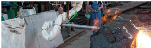
Рис. 23. Процесс резки слитка толщиной 1000 мм горизонтальным резаком при движении его сверху - вниз. Переход через ребро слитка
