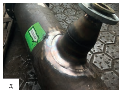
Рис. 2. Модернизация балластной системы т/х «Поморже». Сварка медно-никелевых труб (TIG 141) диаметром 324x4 мм. Сборочные работы: а), б), в) - до ремонта; г), д) сварочные работы до и после сварки
