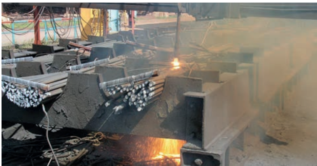
Рис. 13. Резка пучков арматуры
