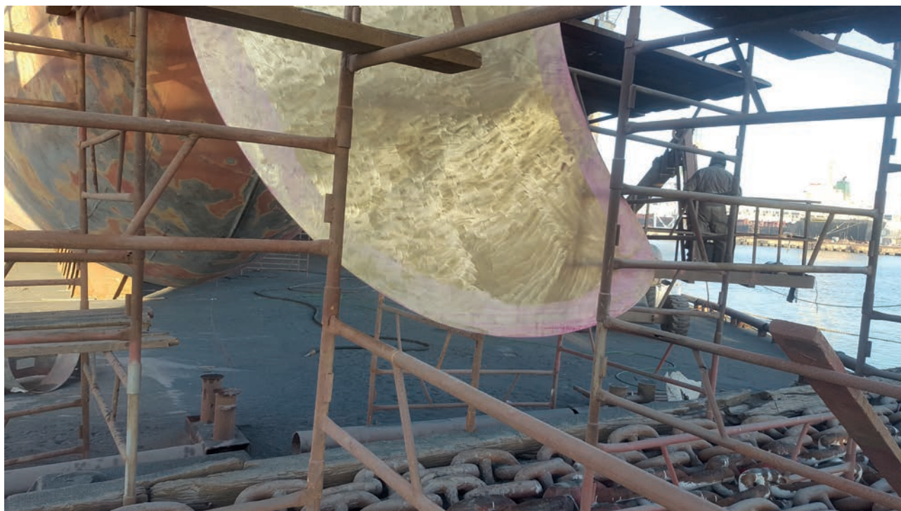
Рис. 3. Полуавтоматическая сварка в инертном газе (MIG 131). Ремонт бронзового гребного винта. Август 2019 г. Винт диаметром 4580 мм, вес – 3450 кг. После ремонта
