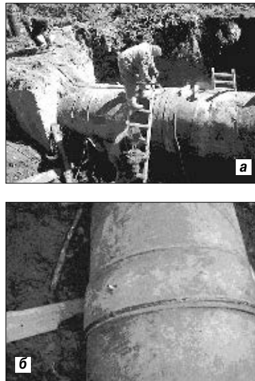
Рис. 8. Ремонт дефектного стыка на действующем магистральном газопроводе «Союз» Ду1400: а — сборка нахлесточно-стыковых соединений; б — внешний вид усиливающей двухслойной муфты
