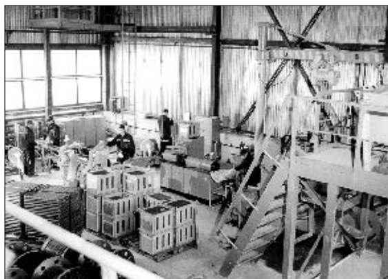
Рис. 1. Линия изготовления электродов
