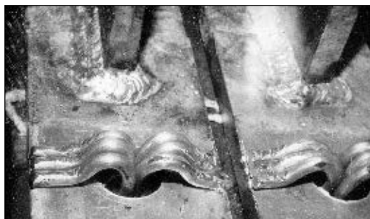
Рис. 3. Пример соединения шести прутков-компенсаторов из ЭКП с алюминиевым шинопроводом
