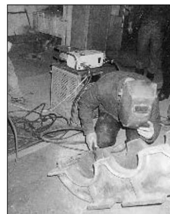
Рис. 3. Приварка элементов алюминиевого шинопровода электролизера полуавтоматом ПШ107ВА
