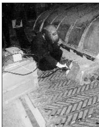
Рис. 3. Приварка элементов алюминиевого шинопровода электролизера полуавтоматом ПШ107ВА
