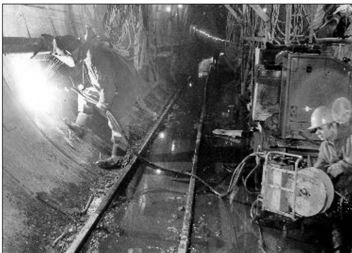
Рис. 1. Сварка полуавтоматом ПШ107В трубы туннеля на глубине 80 м
