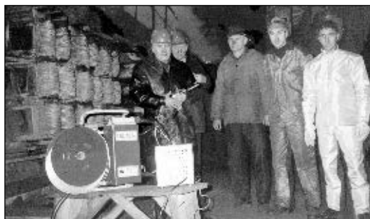
Рис. 2. Сварка полуавтоматом ПШ107ВА элементов алюминиевой ошиновки печи графитации
