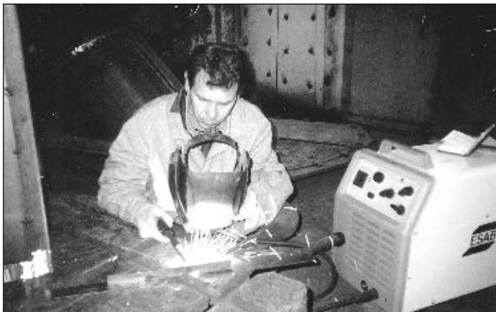
Механизованная сварка плавящимся электродом
