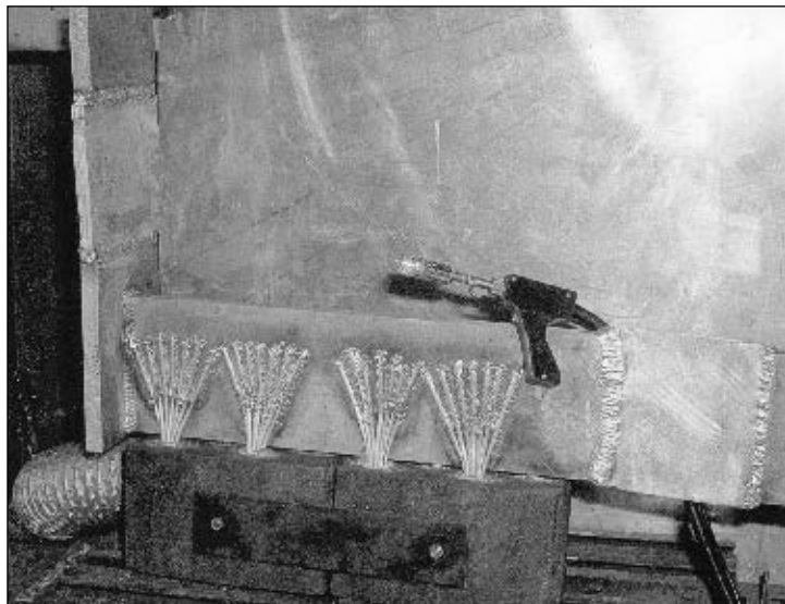
Рис. 2. Полностью сварное соединение анодного бруса с алюминиевым шинопроводом
