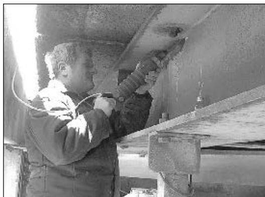
Рис. 5. Упрочнение с помощью ВМП ремонтных швов пролетного строения эксплуатируемого железнодорожного моста
