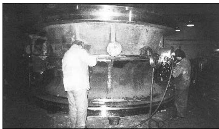
по горячему пневмоинструментом. Предварительный и сопутствующий подогревы выполняли четырьмя газовоздушными горелками. Температуру подогрева поддерживали в переделах 200–250 °С. Чашу сразу после сварки подвергли отпуску в печи при 560–600 °С. Выдержку определяли из расчета 3 мин на 1 мм толщины свариваемого металла. Остыивание в печи проводили со скоростью 50 °С/ч до 100 °С с дальнейшим остыванием на воздухе.
