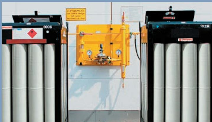
Разрядная рама с подключенными 16-местными ацетиленовыми бандлами
