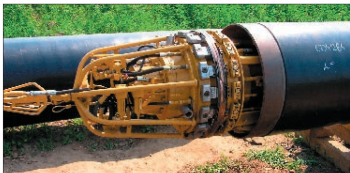
Рис. 2. Центратор труб с устройством для формирования внутренней стороны шва
