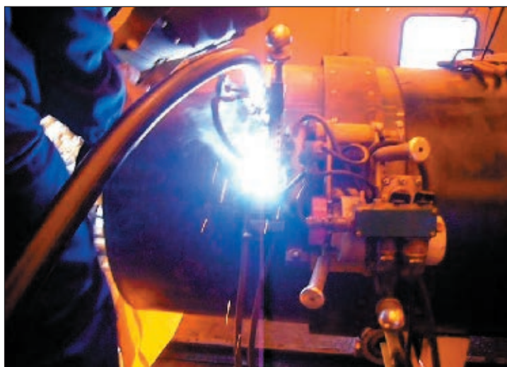
Рис. 3. Сварка неповоротного стыка труб порошковой проволокой Megafil®715B–А
