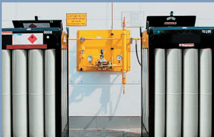
Разрядная раampa с подключенными ацетиленовыми бандлами вместимостью 160 кг
