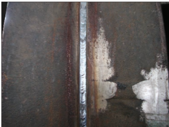
Рис. 6. Внешний вид стыка труб, выполненного автоматической электродуговой сваркой порошковой проволокой с принудительным формированием шва
