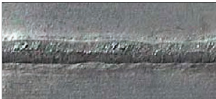
Рис. 1. Образец, пораженный общей коррозией
