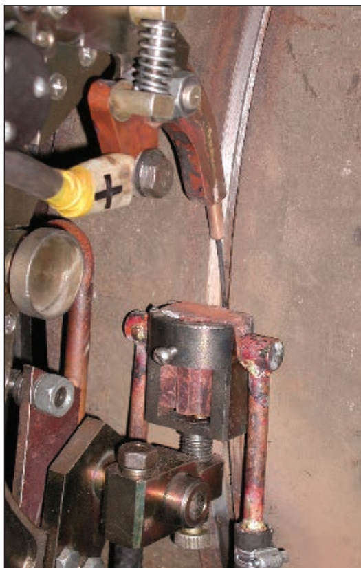
Рис. 2. Установка сварочной головки на стык труб
