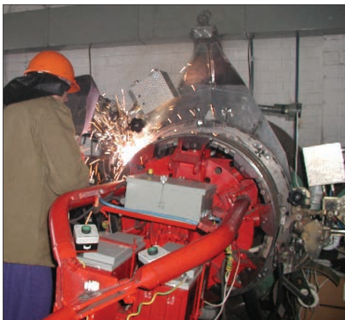
Рис. 3. Сварка корневого шва на медном секционном подкладном кольце внутри-трубного центризатора
