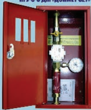
ПОСТ ГАЗОРАЗБОРНЫЙ ГОРЮЧЕГО ГАЗА ПГУ-5-3 ДМ «ДОНМЕТ 827»
