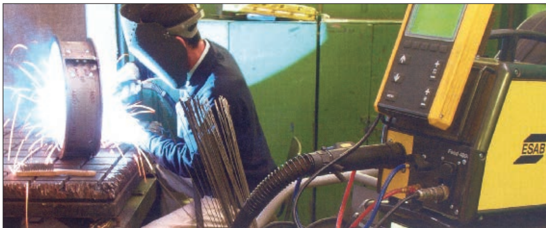
Рис. 5. Дуговая сварка порошковой проволокой марки FilArc PZ6166 кольца с использованием инверторного источника питания AristoMig 500
