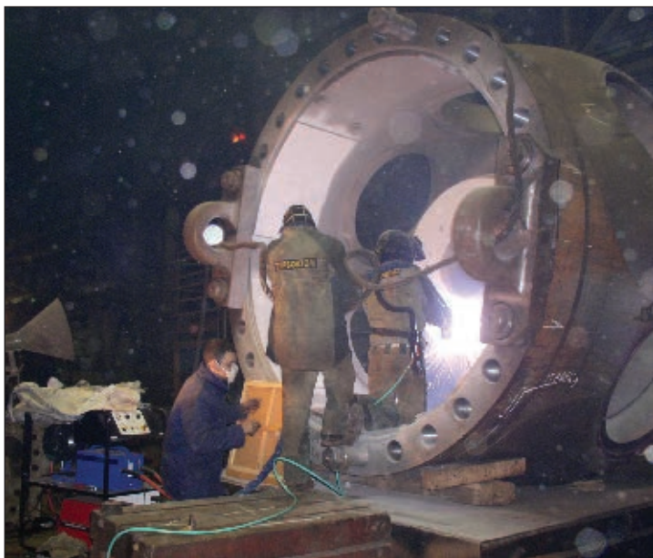
Рис. 5. Газотермическое напыление антикоррозионного слоя на внутреннюю поверхность корпуса гидротурбины Киевской ГЭС
