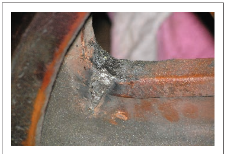
Рис. 8. Общий вид сварного шва на ступице зубчатого колеса
