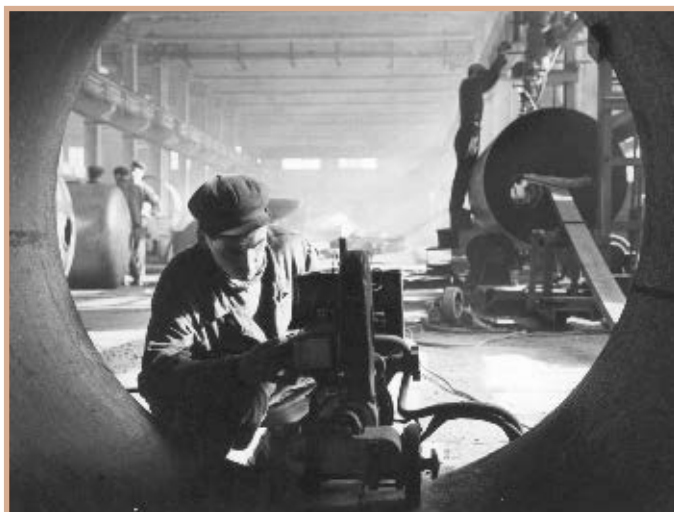
Автоматическая сварка по флюсу алюминиевой обечайки
