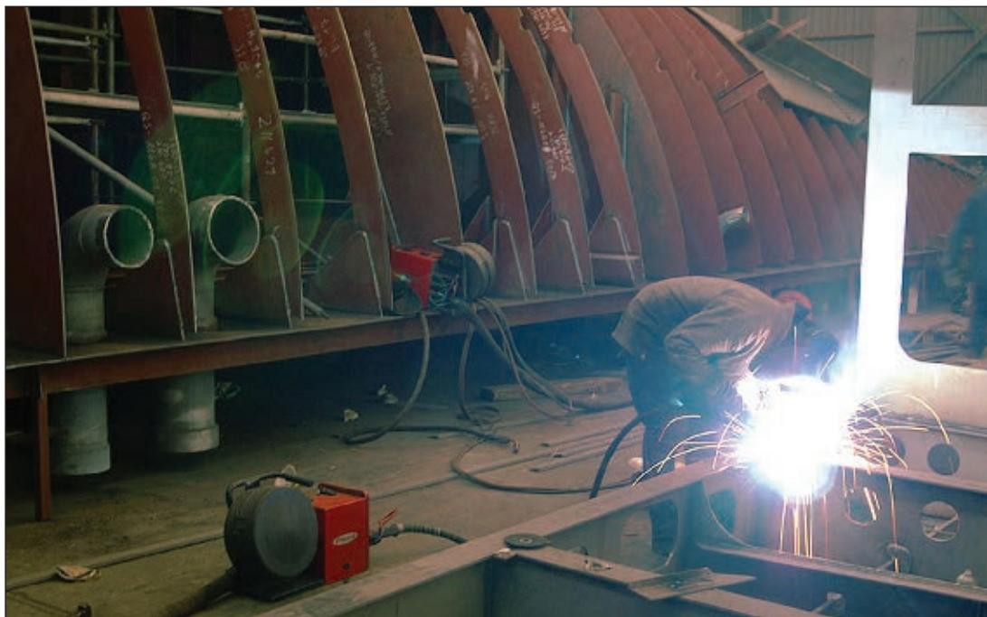
Рис. 2. Сварка на каркасе судна. Предприятие J&K делает ставку исключительно на сварочные системы Fronius
