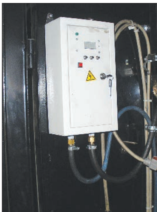
Рис. 3. Блок системы подачи и регулирования расхода аргона
