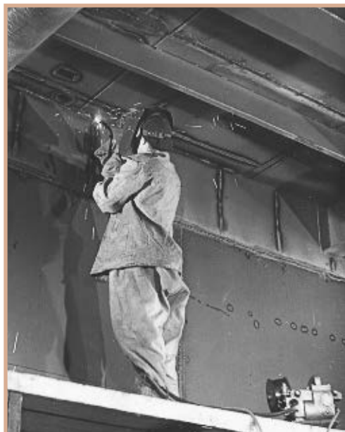
Сварка бортовой секции с подпалубной
