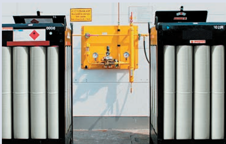
Разрядная рампa с подключенными ацетиленовыми бандлами вместимостью 160 кг
