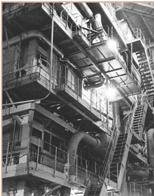
Первый советский прямоточный котел высокого давления (140 атмосфер). Разработан Л.К. Рамзиным (1931), был впервые введен в действие в 1933 г. на ТЭЦ-9 Мосэнерго (фото МИРМЭ, 1933)
