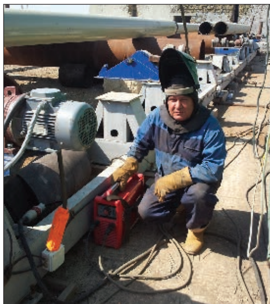
Аппараты TransPocket позволяют выполнять высококачественную сварку неповоротных стыков трубопровода покрытыми электродами различных типов
