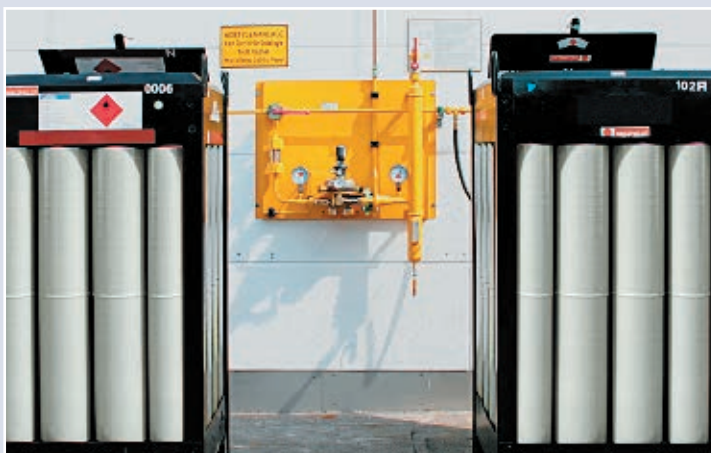
Разрядная рампа с подключенными ацетиленовыми бандлами вместимостью 160 кг
