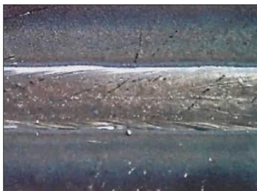
Рис. 22. Внешний вид стыкового шва
