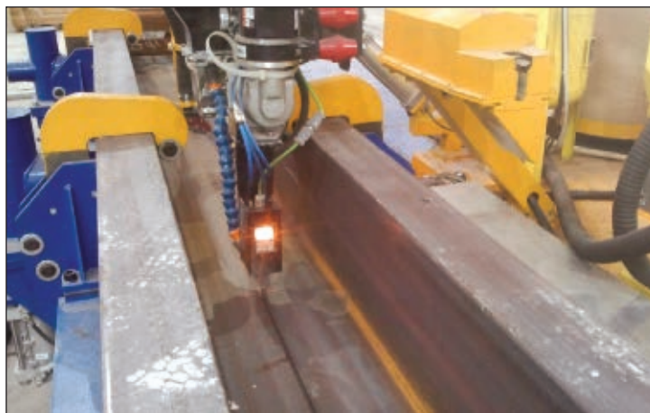
Рис. 19. Автоматическая сварка под флюсом внутреннего шва хребтовой балки
