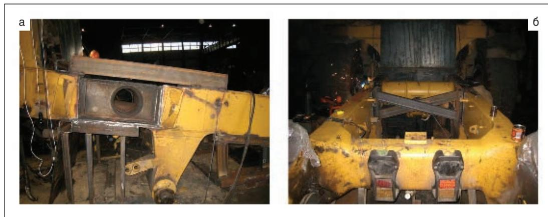
Рис. 4. Установка новой центральной поперечной опоры с использованием дополнительных ребр жесткости (а) и общий вид узла рамы после восстановления (б)
