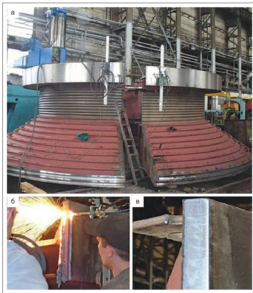
Рис. 8. Разделка кромок под сварку секций барабана шахтоподъемной машины на монтажной площадке с помощью резака РГКМ-2-SR: а — барабан, подготовленный к резке, б — резка; в — поверхность реза
