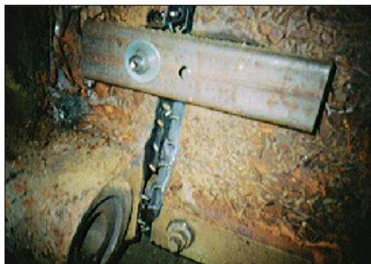
Рис. 2. Подготовка траверсы к сварке
