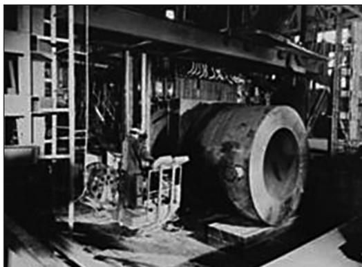
Сварка цилиндра гидравлического прессы усилием 65000 тс, толщина свариваемого металла 2640 мм, масса 110 т (1974 г.)
