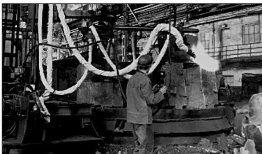
Рис. 5. Термообрубной цех. Переносная установка УОПП-1 для механизированной газокислородной резки прибылей в работе. За пультом управления газосварщик бюро газопламенной обработки Л. П. Кубышка (1975 г.)
