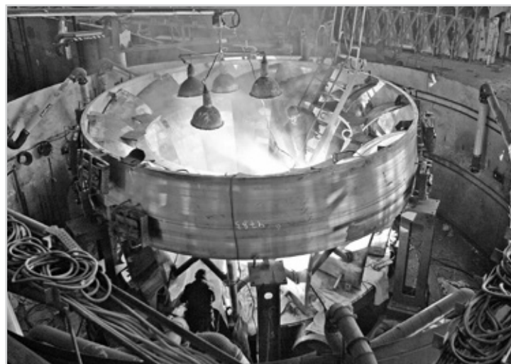
Рис. 5. Сварка радиально-осевого рабочего колеса гидротурбины
