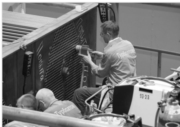
Рис. 2. Орбитальная сварка титановых трубок в трубной доске конденсатора
