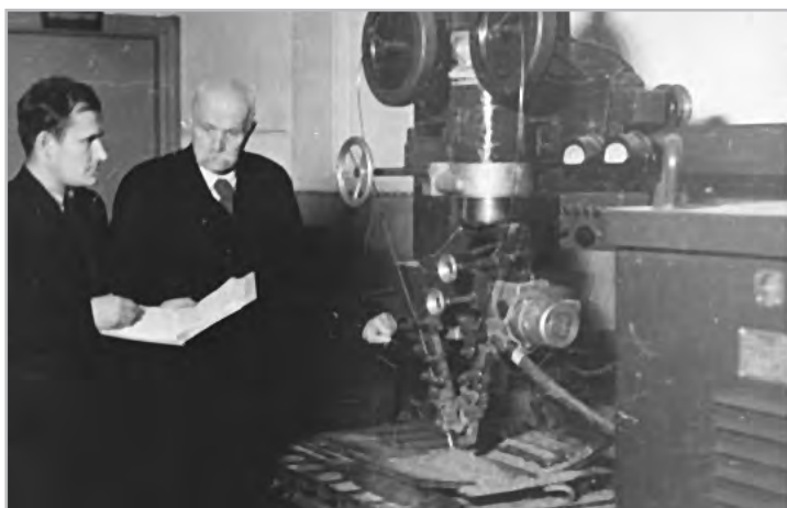
Е. О. Патон и А. М. Макара. Скоростная сварка двумя дугами ускорила производство труб. (ИЭС, 1949 г.)
