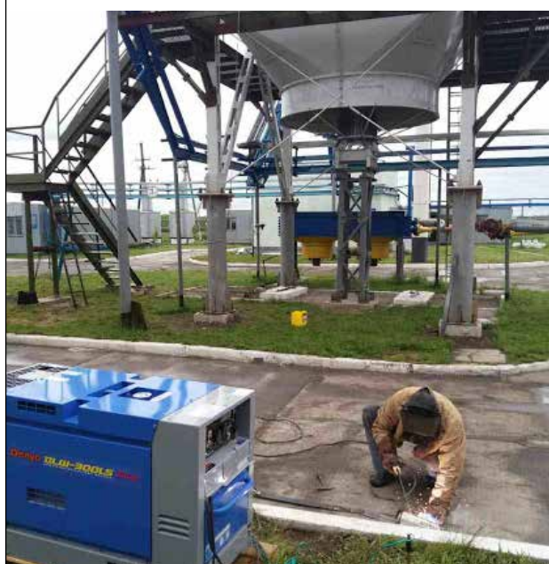
Использование сварочного агрегата Denyo DLW-300LS на объектах ПАО «Укргазвидобування»
