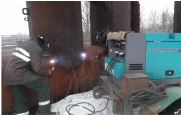
Рис. 3. Ремонт пульповодов шламохранилища цеха шламового хозяйства обогатительной фабрики ЧАО «Полтавский ГОК» с помощью двухпостового сварочного агрегата DENYO
