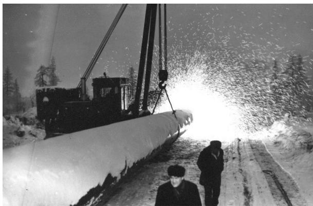
Рис. 4. Сварка комплексом «Стык» на трассе Уренгой – Ужгород, 1969 г.
