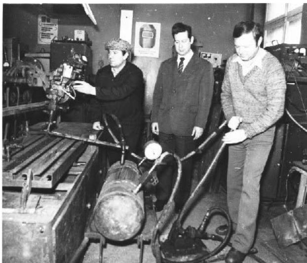
Рис. 2. Сварщик Руденко Н.И., к.т.н. Иващенко Г.А. и инженер Бут В.С. Испытание образца трубы, отремонтированного сваркой под давлением
