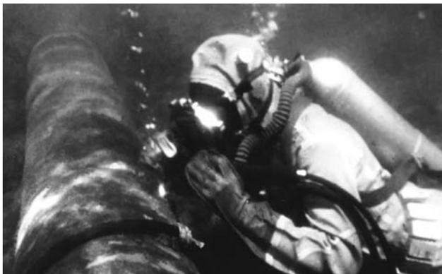
Рис. 4. Ремонт трубопровода под водой
