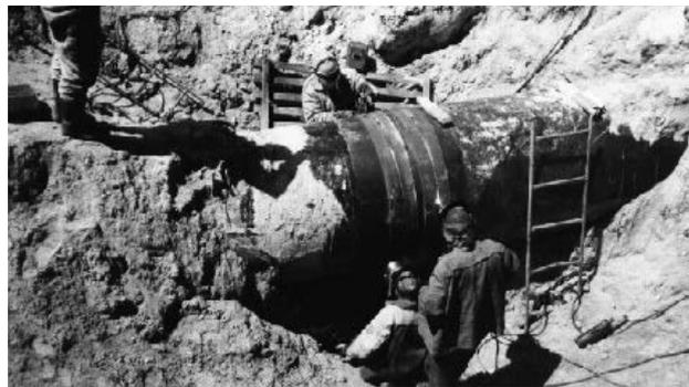
Рис. 3. Ремонт магистрального трубопровода в режиме эксплуатации
