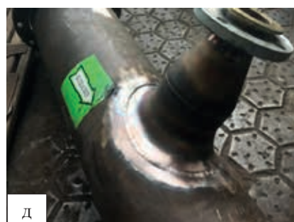
Рис. 2. Модернизация балластной системы т/х «Поморже». Сварка медно-никелевых труб (TIG 141) диаметром 324x4 мм. Сборочные работы: а), б), в) - до ремонта; г), д) сварочные работы до и после сварки
