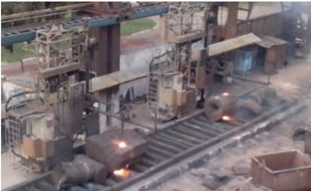
Рис. 23. Участок подготовки шихты. Одновременная работа двух машин газовой резки УОПП-1
