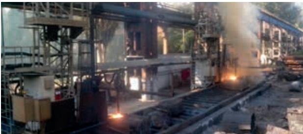
Рис. 22. Участок подготовки шихты. Одновременная работа двух машин газовой резки УОПП-1; на переднем плане – резка заготовки из углеродистой стали, на заднем плане – резка заготовки из нержавеющей стали 08X18H10T
