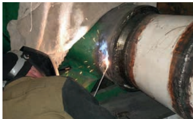
Ремонт корпуса насоса (сталь 35Л), ОАО «Укргазнафта», г. Кременчуг
