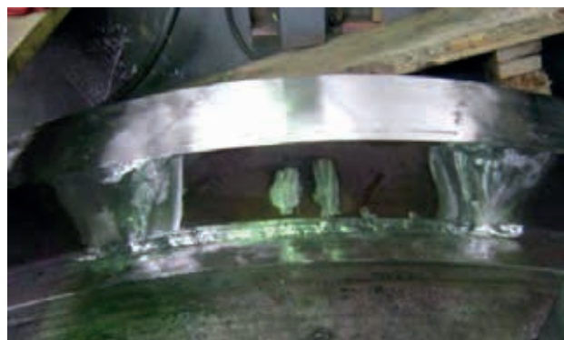
Ремонт бандажа окомкователя (масса 30 т, Сталь 50), ОАО «Полтавский ГОК», г. Горишни Плавни
