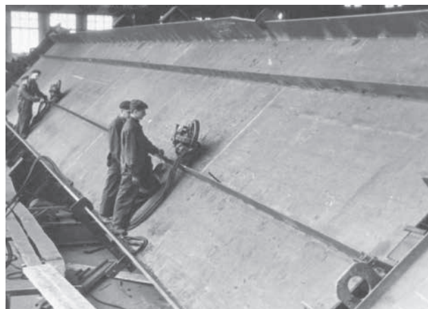
Балки моста Патона на Днепропетровском заводе металлоконструкций изготавливали автоматической сваркой
