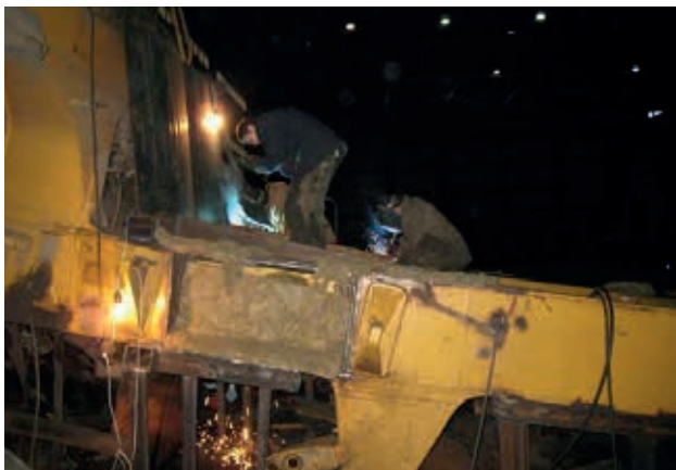
Восстановление сваркой рамы автосамосвала САТ 785С (стали 10ГС, 20ГС, 25Л), ОАО «НК ГОК», г.Кривой Рог. Сварка соединений при вставке новой центральной поперечной опоры
