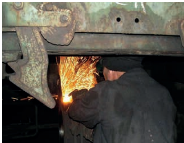
Рис. 18. Ремонт железнодорожного вагона с помощью резака Р1Ш-СП. Срезка заклепок
