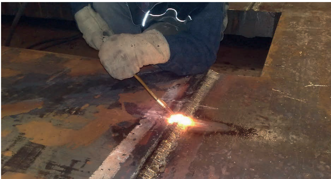
Рис. 17. Ремонт разделки под сварной шов на металлоконструкции коробчатого сечения
