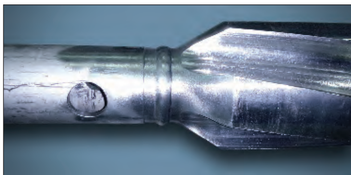
Рис. 3. Внешний вид сварного шва
