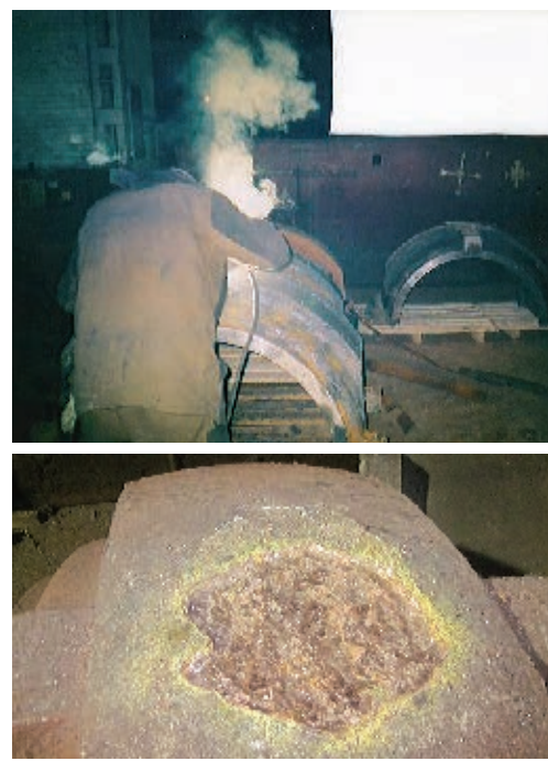
Рис. 5. Сварка крышки подшипника. Электроды «Комсомолец»
