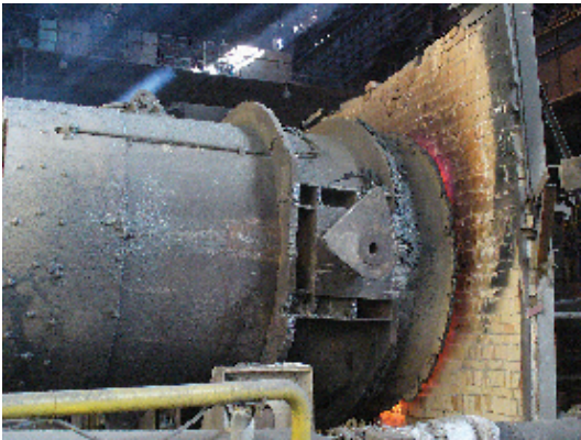
Рис. 6. Горизонтальный стенд для 90-тонных сталеразливочных ковшей шибера типа в процессе разогрева горелкой ГНД-100 М
