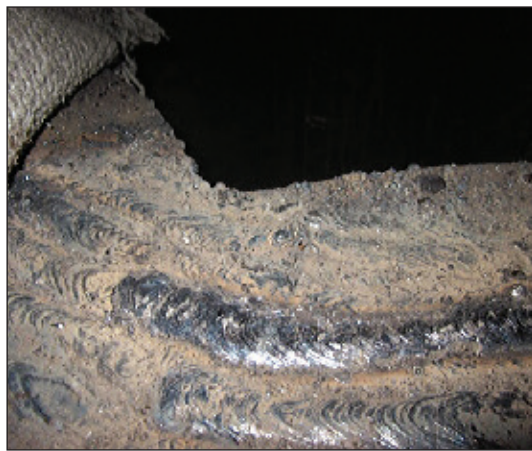
Рис. 4. Вырезка отверстия в шатуне толщиной 435 мм с помощью переносной газорезательной машины и резака РГКМ-4
