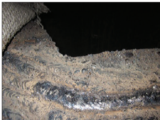
Рис. 4. Плазменная резка нержавеющей стали на машине CORTINA DP4000
