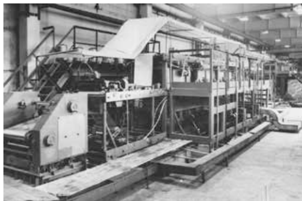
Рис. 1. Монтаж линии обезжиривания алюминиевого протектора
