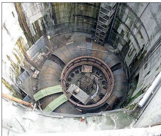
Рис. 2. Спиральная камера гидроагрегата № 1 Днестровской ГАЭС
