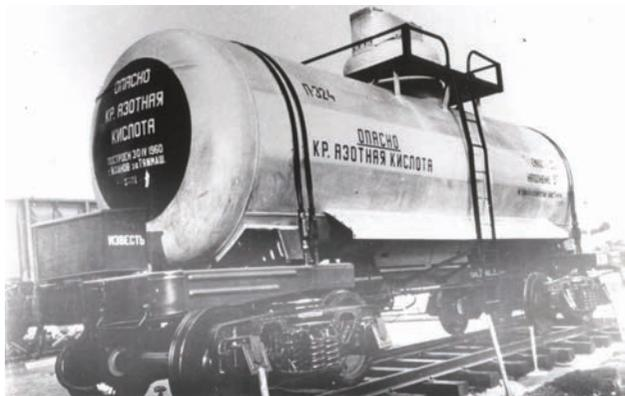
Рис. 2. Сварная железнодорожная цистерна из алюминиевого сплава
