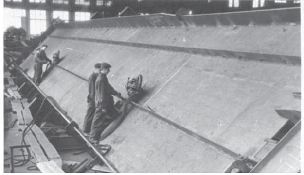
Рис. 7. Сварка балки для моста им. Е.О. Патона на Днепропетровском заводе металлоконструкций, 1952 г. В 1946–1947 гг. в ИЭС создана технология сварки со скоростью 160-200 м/ч. В 1949 г. запущен первый непрерывный трубоэлектросварочный стан на Харцызском трубном заводе (рис. 8). С 1950-х гг. такие линии начали строиться на др. заводах [24] (Сталинская премия 1950 г., Б.И. Медовар, Р.И. Лашкевич и др.).
