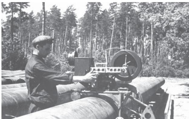
Рис. 3. Сварка трактором ТС-17 стыков трубопроводов в полевых условиях
