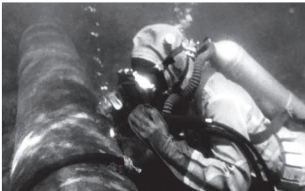
Рис. 4. Ремонт трубопровода под водой
