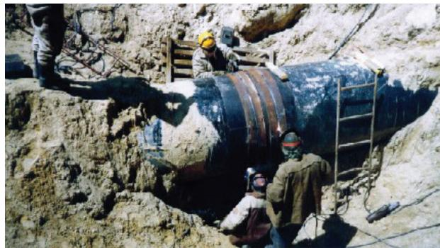
Рис. 3. Ремонт магистрального трубопровода в режиме эксплуатации
