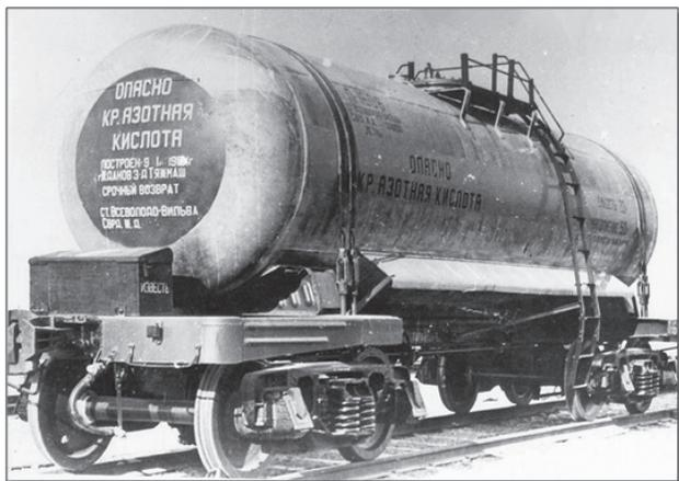
Рис. 1. Железнодорожная цистерна из алюминия высокой чистоты для перевозки химических продуктов: сварена дуговым автоматизированным способом с использованием плавящегося электрода и флюсов
