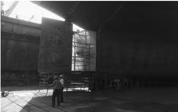
Рис. 6, в. Сварочные работы проводились непосредственно в плавучем доке в специально оборудованном укрытии (шалаше) для обеспечения необходимых условий, требуемых технологией сварки
