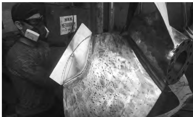
Рис. 5, б. Процесс приварки наделки, промежуточная зачистка после каждого прохода сварного валика с целью исключения возможных дефектов в сварном шве
