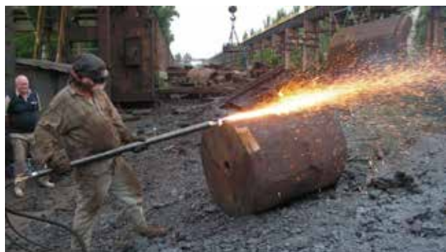
Рис. 6. Испытание резака РГKM-800 в производственных условиях
