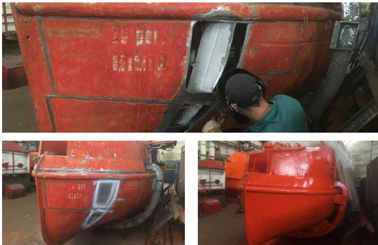
Рис. 2. Полуавтоматическая сварка плавящимся электродом в среде аргона (MIG 131). Ремонт алюминиевых спасательных шлюпок т/х «ВЕРЕС». Материал: алюминиевый сплав АМг5
