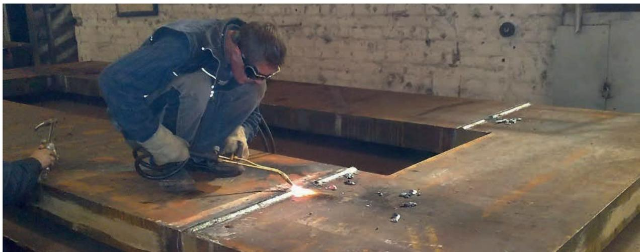
Рис. 16. Вырезка дефектов в корне сварного шва на металлоконструкции коробчатого сечения
