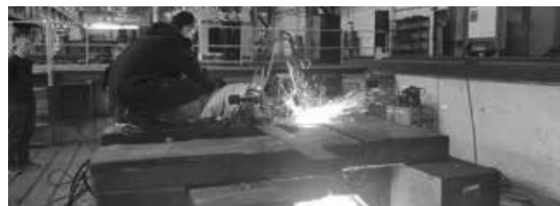
Рис. 2. Процесс вырезки трещины корпуса бойка двумя параллельными резами
