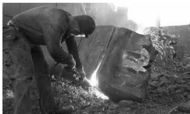
Рис. 16. НКМЗ. Копровый цех. Резка крупного отхода поковки на габаритные куски – 2
