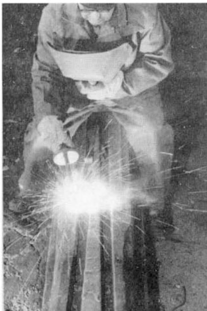
**Рис. 1. Полуавтоматическая наплавка крестовины**
