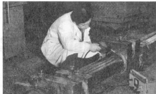
**Рис. 3. Подготовленный к пайке коленчатый вал при проверке герметичности паяльных зазоров**
