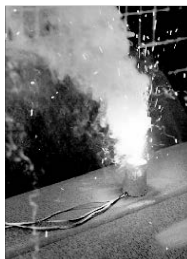
Рис. 2. Приварка медного кабеля к трубе с использованием керамического патрона ТППГ-2,5/16
