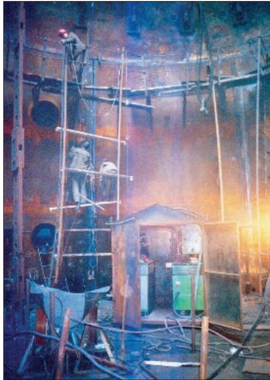
Рис. 2. Электрошлаковая сварка вертикального стыка монтажных блоков корпуса доменной печи
